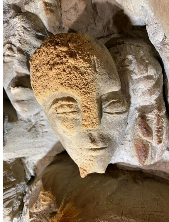
Personnage D86 : recouverts d'efflorescences de couleur rouille entre 2005 et 2023
