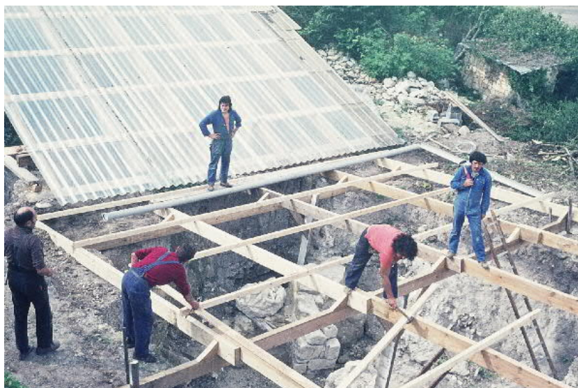
Installation de la couverture translucide (Photo B. Gacongne)
